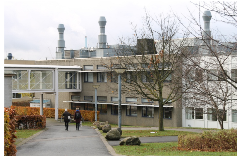
Figur 5 Eksteriør. Synlig, uinddækket ventilationsinstallation, Roskilde Universitets Center.
