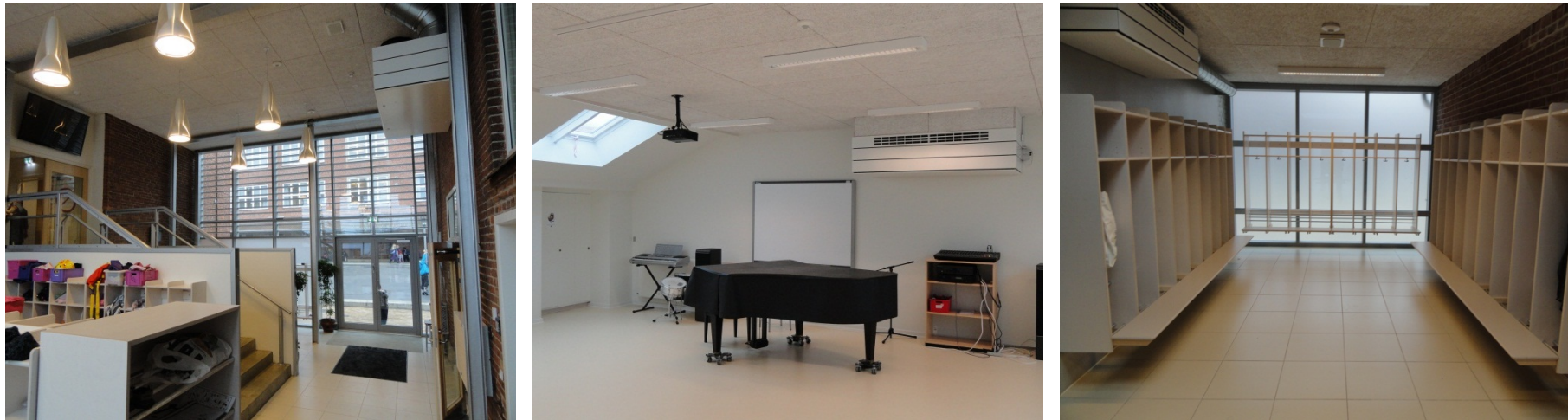
Figur 7 Interiør. Selvstændige, synlige ventilationsaggregater med deres egen detaljerede æstetik.
