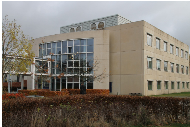
Figur 4 Eksteriør. Synlig, inddækket ventilationsinstallation, Roskilde Universitets Center.
